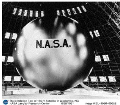
**Figure 1. Satellite ECHO I (NASA) : ballon réfléchissant de 30 m de diamètre utilisé comme antenne relais.**
