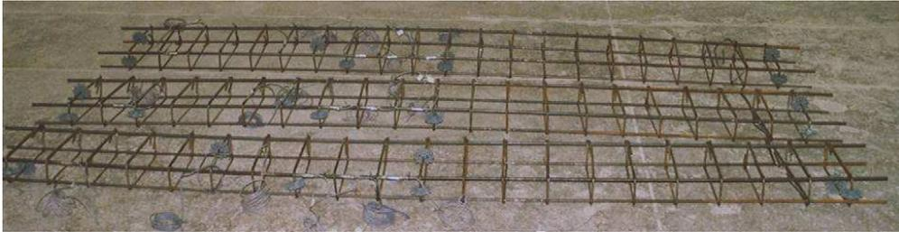
Fig. 3.4. : Mise en place des jauges de déformation sur les armatures en acier.
