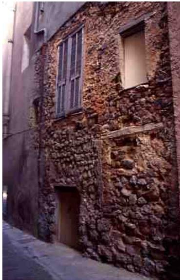
FIG. 1.16 – *Exemple d'ouverture bouchée à la Bollène Vésubie.*
