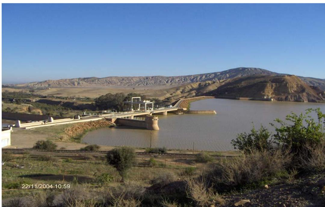
**Le Barrage de Fergoug:** La digue en enrochement & l'évacuateur de crues
