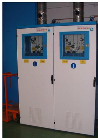
**Figure IV.16** : Installation de la première détente (installation Air Liquide)
