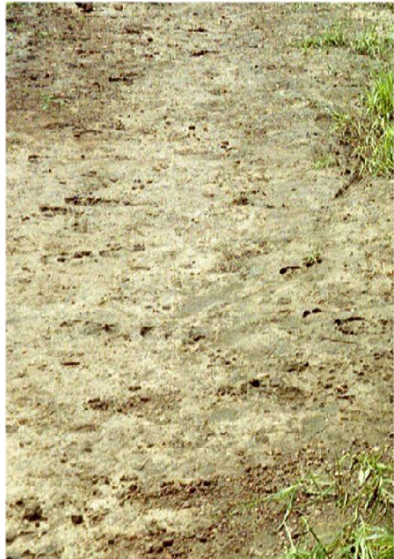
Photo n°17 : Pellicule superficielle sablo-argileuse
