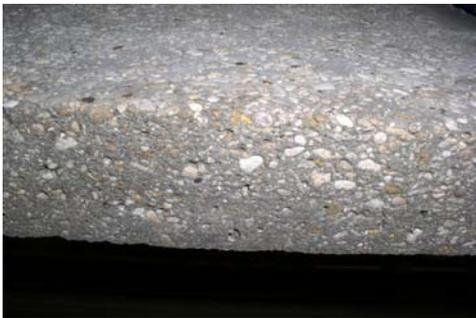
Photo III.3- Surface du béton sablée
